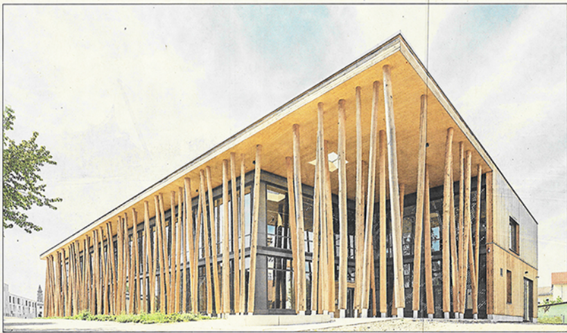
Die Eingangsfassade des NAWAREUM in Straubing empfängt die Besucher*innen mit einer Baumallee aus Lärchenholzstämmen. Am Eingangsbereich erweitert sich die Allee dann zu einem Vorplatz.
