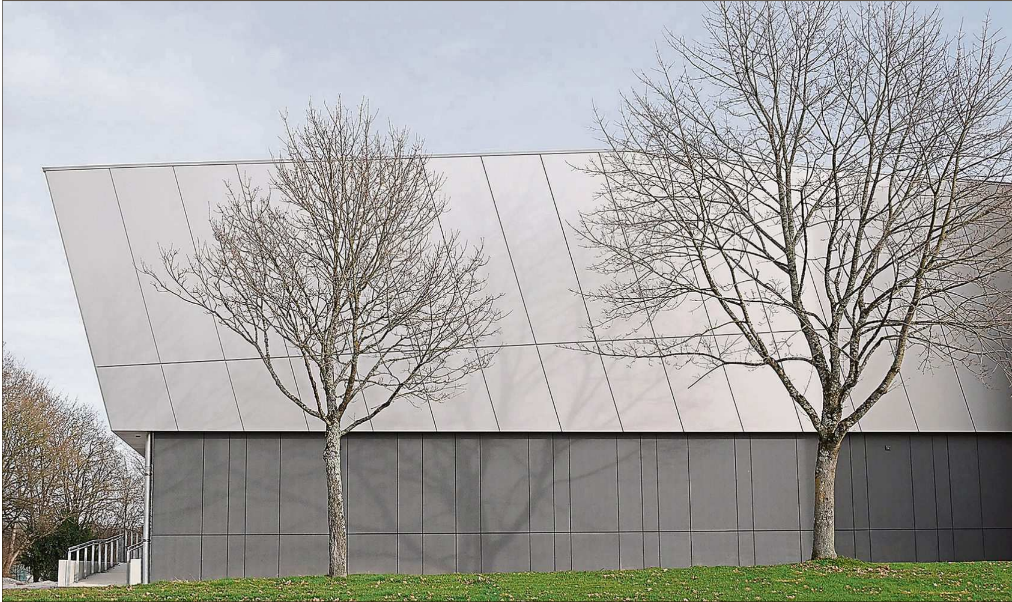
Ansicht der neuen Altdorfer Dreifachsporthalle von Südwesten.
