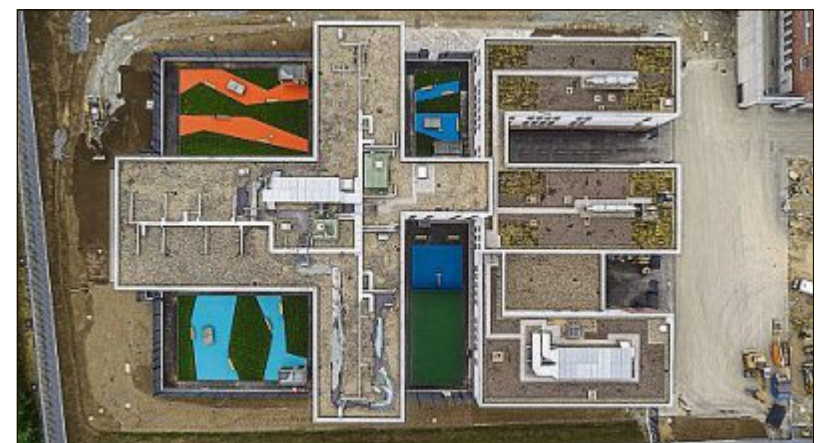
Der zentrale Dienstraum und eine Dachansicht der neuen Anlage.
